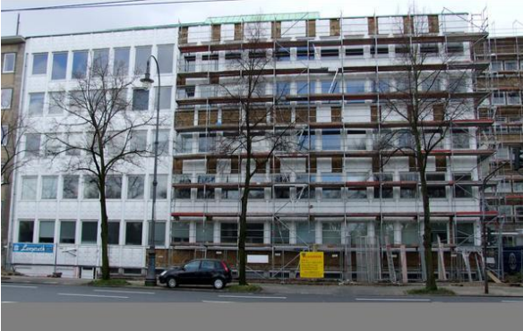
Revitalisierung einer Büroimmobilie Baujahr 1969
